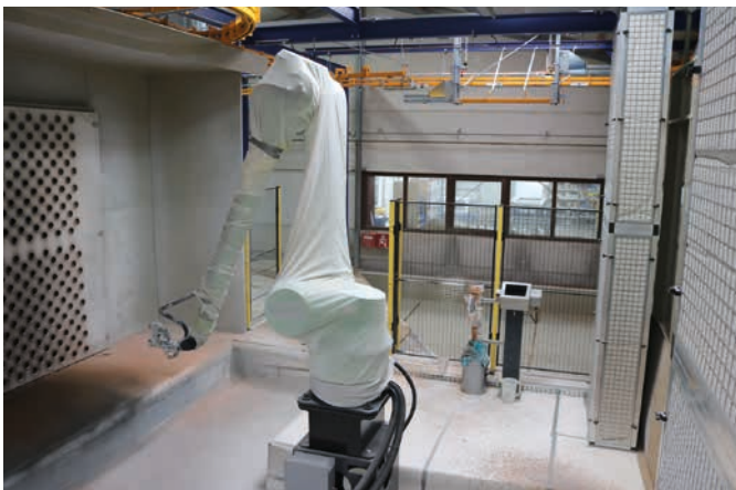
▲ (von links) Neben einem horizontalen Einzelteilimprägniersystem besteht die neue Anlage bei Herbert-Fenster aus einem Flut- und Spritzkreislauf mit Lackierroboter (Bilder: Range + Heine)
