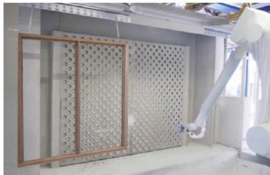
Jüngste Investition im Hause Walter ist ein hochmoderner Oberflächenbereich für Holz- und Holz-Alu-Fenster, komplett konzipiert von Range & Heine. Hier im Bild ist der Spritzroboter (CMA) im Einsatz zu sehen.
