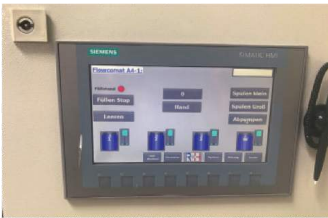
Die Flutanlage bietet einen halbautomatischen Farbwechsel für vier Farben. So stehen immer drei Lasurfarben und eine weiße Grundierung zur Verfügung.
