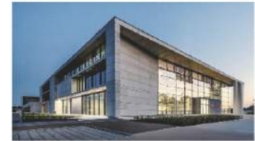
Der neue Solarlux-Standort in Melle.
