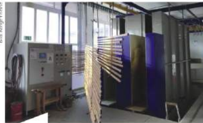
Im ersten Schritt wurden 2016 ein Flutkreislauf mit Power & Free-Fördertechnik und zwei Flutanlagen sowie einem Entfeuchtungstrockner installiert.
