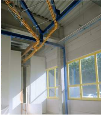
Nebeldüsen verhindern das Antrocknen des Materials während des Abtropfens und damit die Nasenbildung
