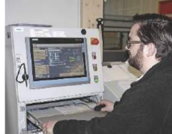
Im Kontrollzentrum: Vom Leitreechner aus lässt sich auf jedes Werkstück zugreifen, das derzeit unterwegs ist.
